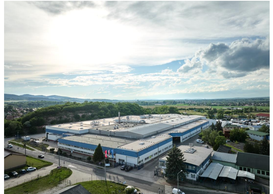
Unser hochmodernes Werk für Statoren und Rotoren für e-Motoren in Tokod (HU).
